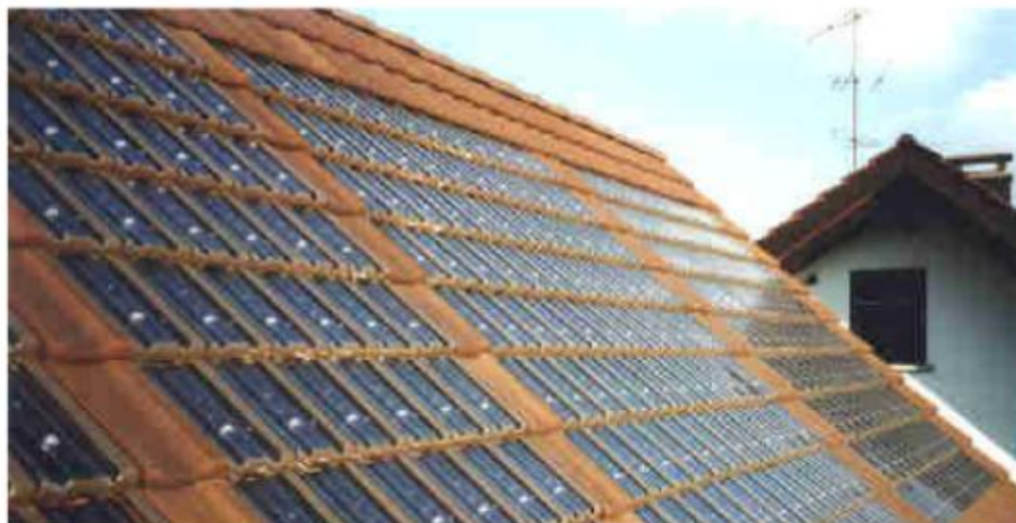
Figura 11. Tejado con papel solar amorfo
