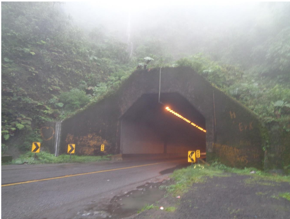
Figura N.º 37 Fotografía del exterior del Túnel Zurquí de día
