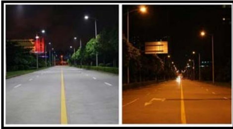
Figura N.º 11. Comparación entre LED y vapor de sodio de alta presión
