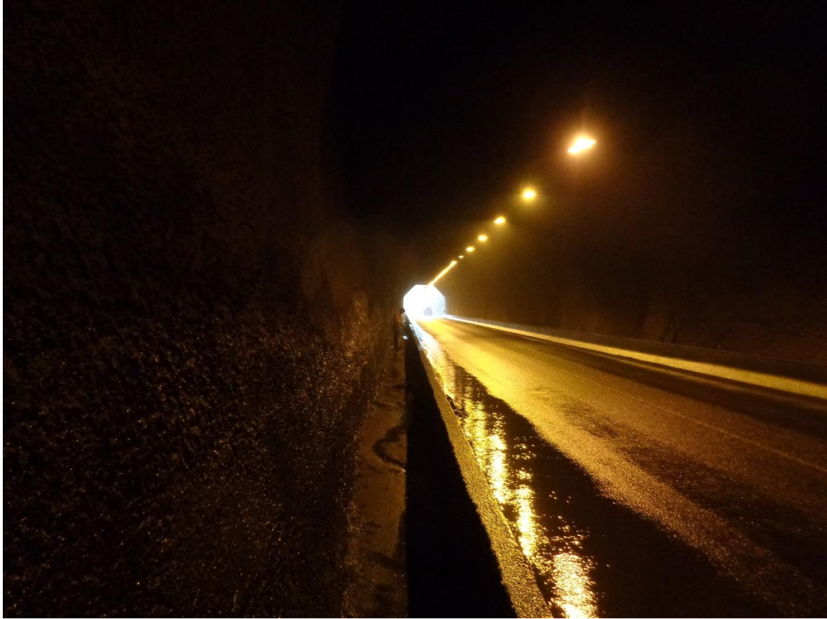
Figura N.º 39 Fotografía del interior del Túnel Zurquí de día
