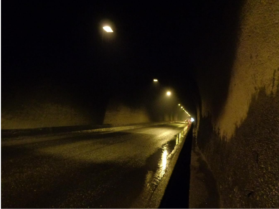
Figura N.º 38 Fotografía del interior del Túnel Zurquí de día
