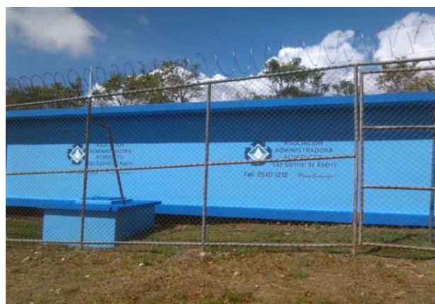
Figura 17. Tanque de almacenamiento 300m 3
