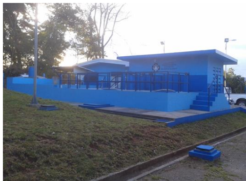
Figura 14. Planta potabilizadora sistema Río Tigre.
