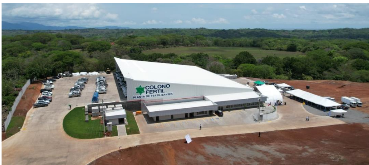
Figura 4. Instalaciones de la planta Colono Fértil-Orotina.
