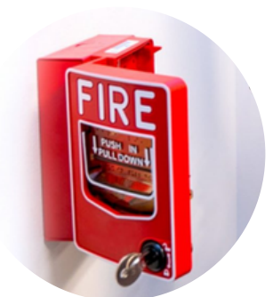
Figura C5.64 Alarma de incendio. Fuente Puertas Asturmex
