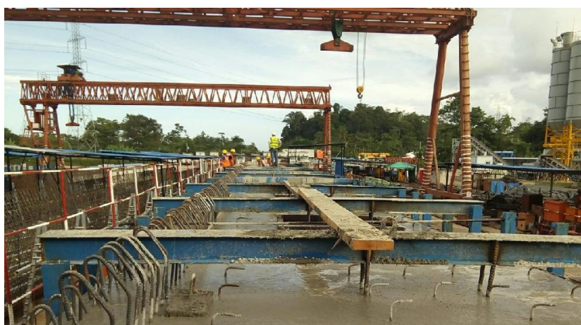
Imagen 14. Proceso de construcción de la Ruta 32
