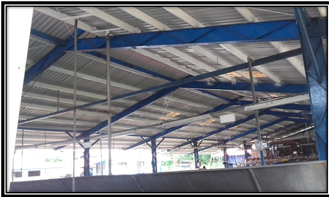
Figura 1. 23 Imagen de la estructura metálica del techo
