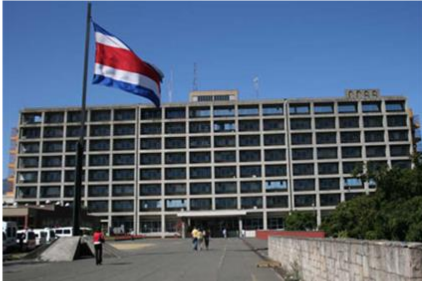
Figura 2 Instalaciones Hospital México
