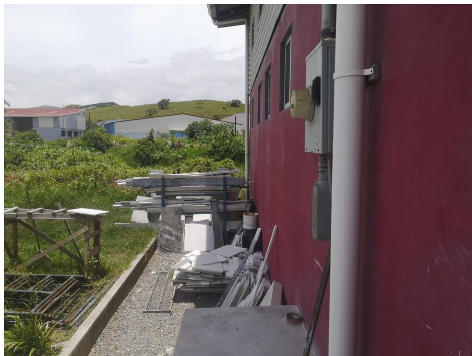
Ilustración 2 Estado actual del frente de GRAMAQUI S.A.
