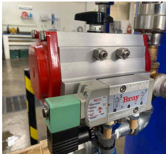
Ilustración 35:Instalación de válvula neumática
