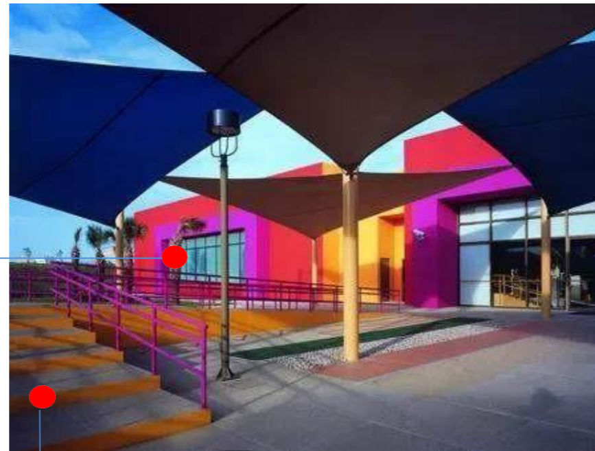
4 Centro de rehabilitación Infantil Tamaulipas, México
