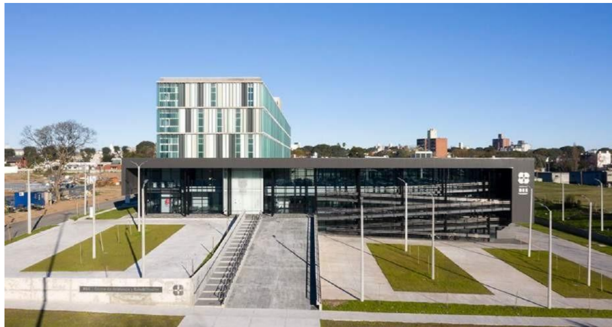
15 Sanatorio y centro nacional de rehabilitación, Montevideo, Uruguay
