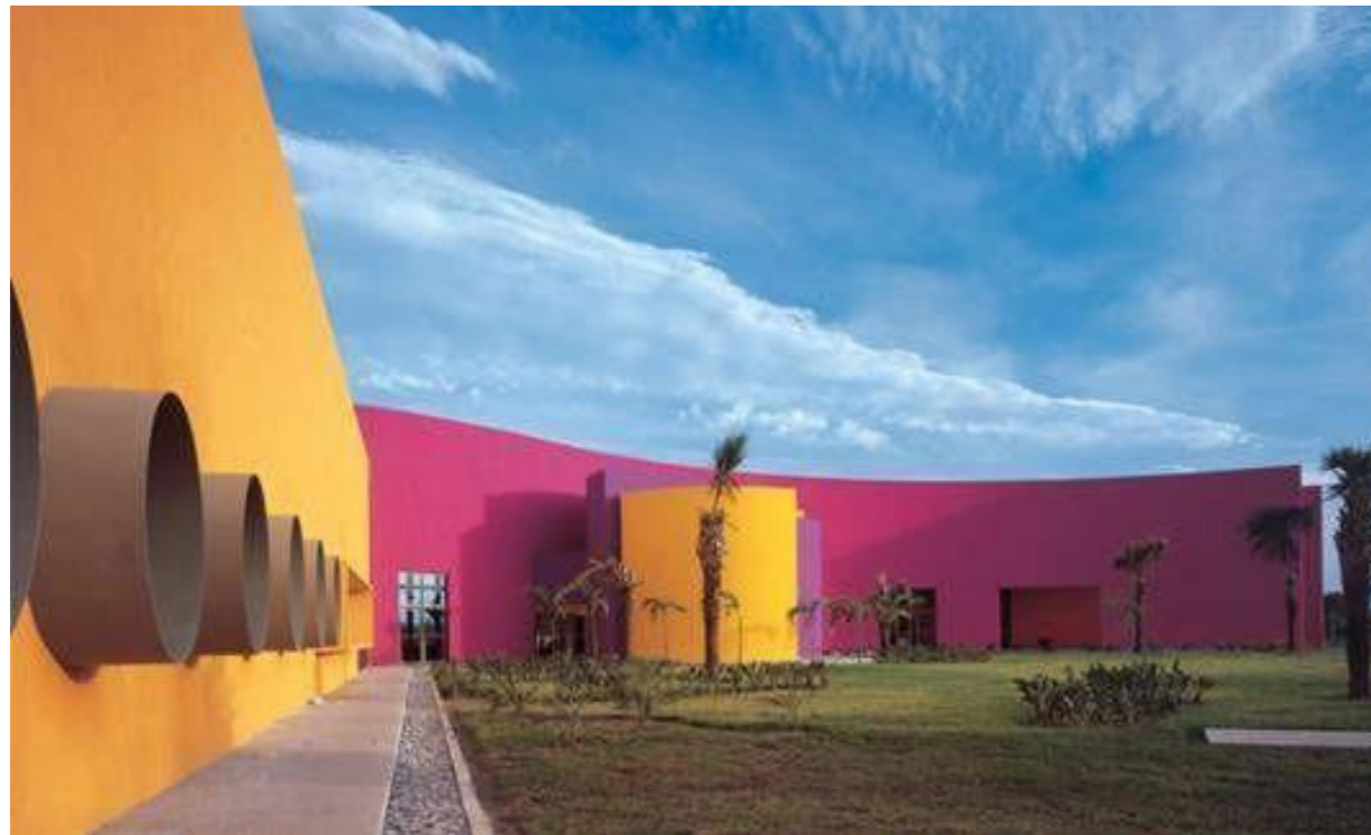
1.1 Centro de rehabilitación Infantil Tamaulipas, México.
