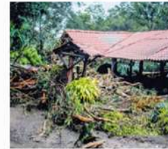
Los estragos que causó el huracán Otto quedaron atrás en Thermomanía, en Bagaces. El sitio ya tiene todos los servicios abiertos y espera recuperar los niveles de visitación anteriores al huracán.
