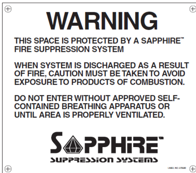
Figura 58. Rótulo de advertencia sobre no ingresar al recinto luego de una descarga de agente.
