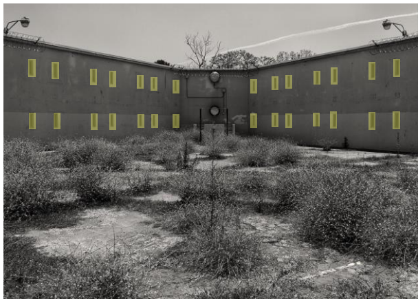
Figura 10: Vista exterior de una Unidad Funcional, en donde se representan las ventanas de cada celda. Fuente: Medium
