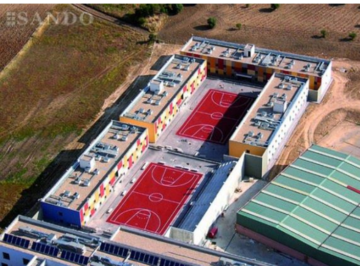
Figura 29: Vista aérea de los módulos en Archidona Fuente: Revista Hoy
