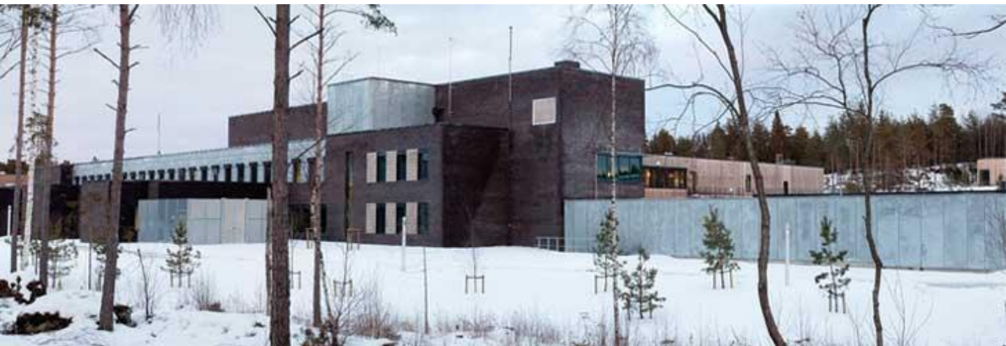
Figura 31: Entrada principal de la Cárcel de Halden
