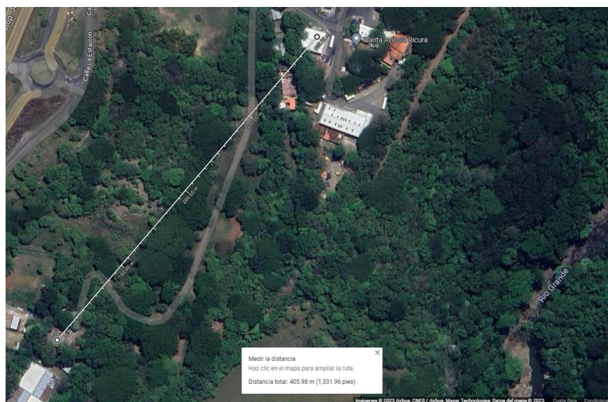
Figura 32 Distancia de los tanques desde la planta
