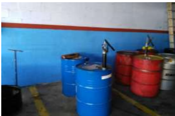
Figura 4.4: Cuarto de lubricantes.
