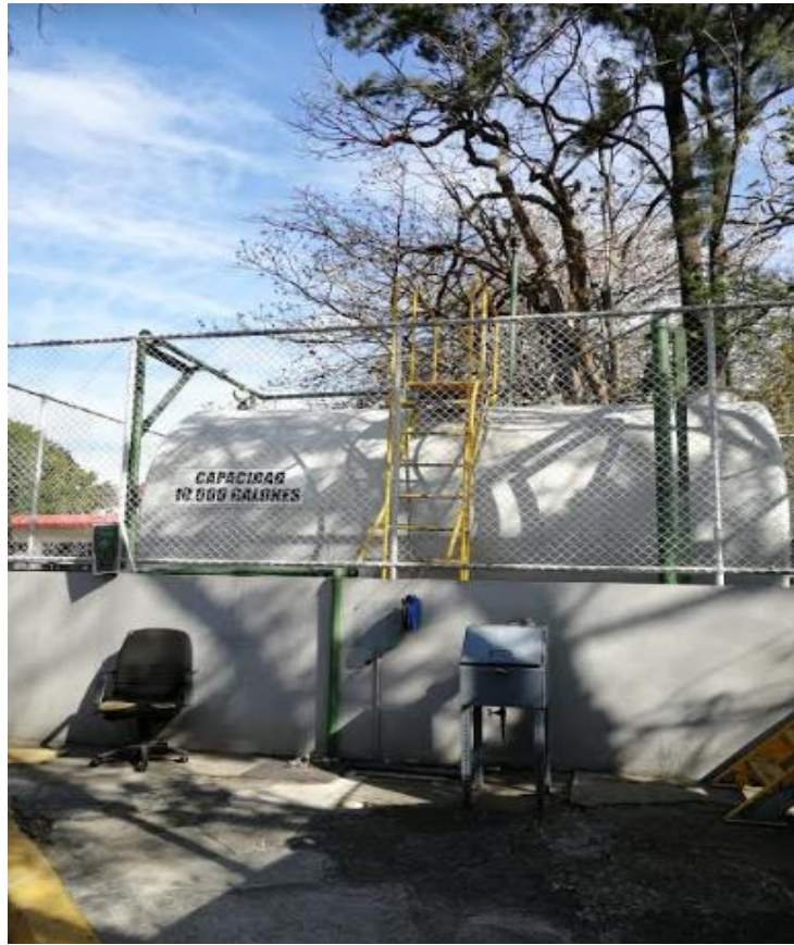
Figura 12. Tanque de Combustible de GASH S.A. Elaboración propia.
