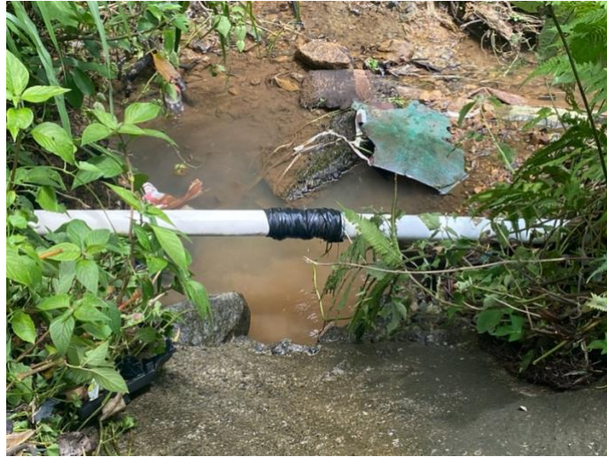
Ilustración 6. Estado Actual de la línea de conducción
