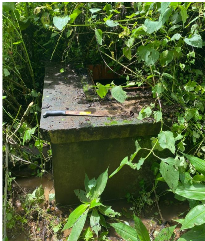
Ilustración 5. Obra actual de la Captación
