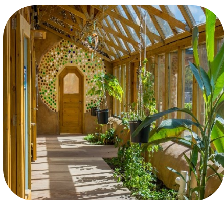
Figura 83. Pared de fondo está construida con botellas de vidrio. Tagma. S.f. https://goo.su/k0tbL
