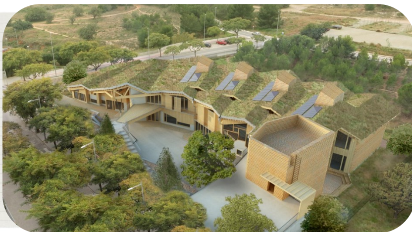
Figura 57. Cubiertas verdes que mejoran el clima del edificio y lo integran con el entorno. Construable. 2019. https://goo.su/LqRP
