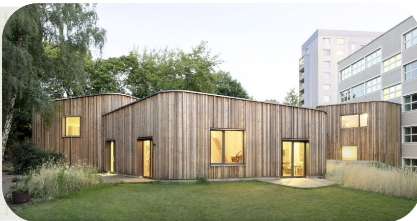
Figura 67. A la derecha se muestra el edificio de la escuela preexistente. Schmidt, 2020. https://goo.su/z349w
