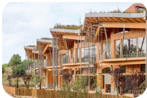
Figura 73. Los ventanales de las aulas se orientan hacia la vegetación colindante.
