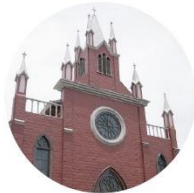
Iglesia María Auxiliadora (1851-1910) Parte del Hospicio de Huérfanos de Cartago Reconstruido en 1910 Restaurada en 2020
