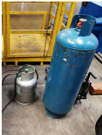
Ilustración 24. Detalle del combustible (gas) del horno
