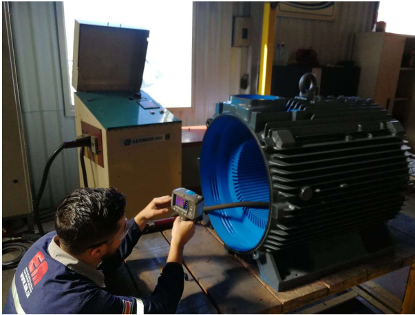
Ilustración 16. Ejecución de prueba núcleo con termografía
