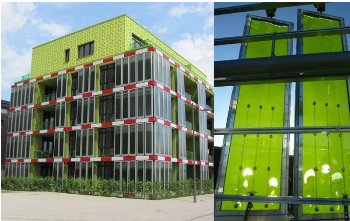
Figura 7. Edificio BIQ, en Hamburgo, abastece parte de su consumo energético a través de paneles que contienen microalgas.
