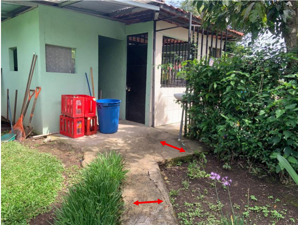
Figura 20. Entrada a instalaciones
