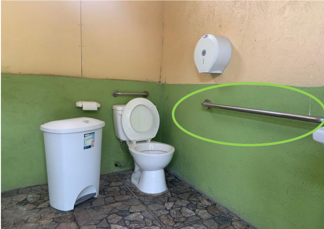
Figura 34. Servicio sanitario adaptado a la Ley N°7600
