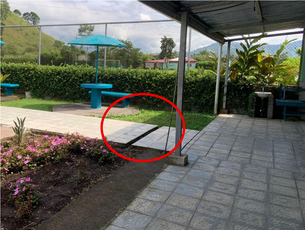
Figura 22. Acceso a los servicios sanitarios
