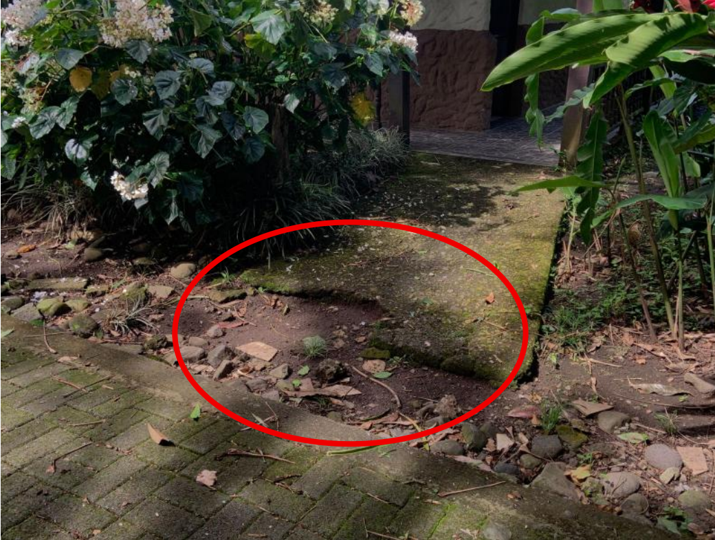
Figura 21. Acceso principal a los baños
