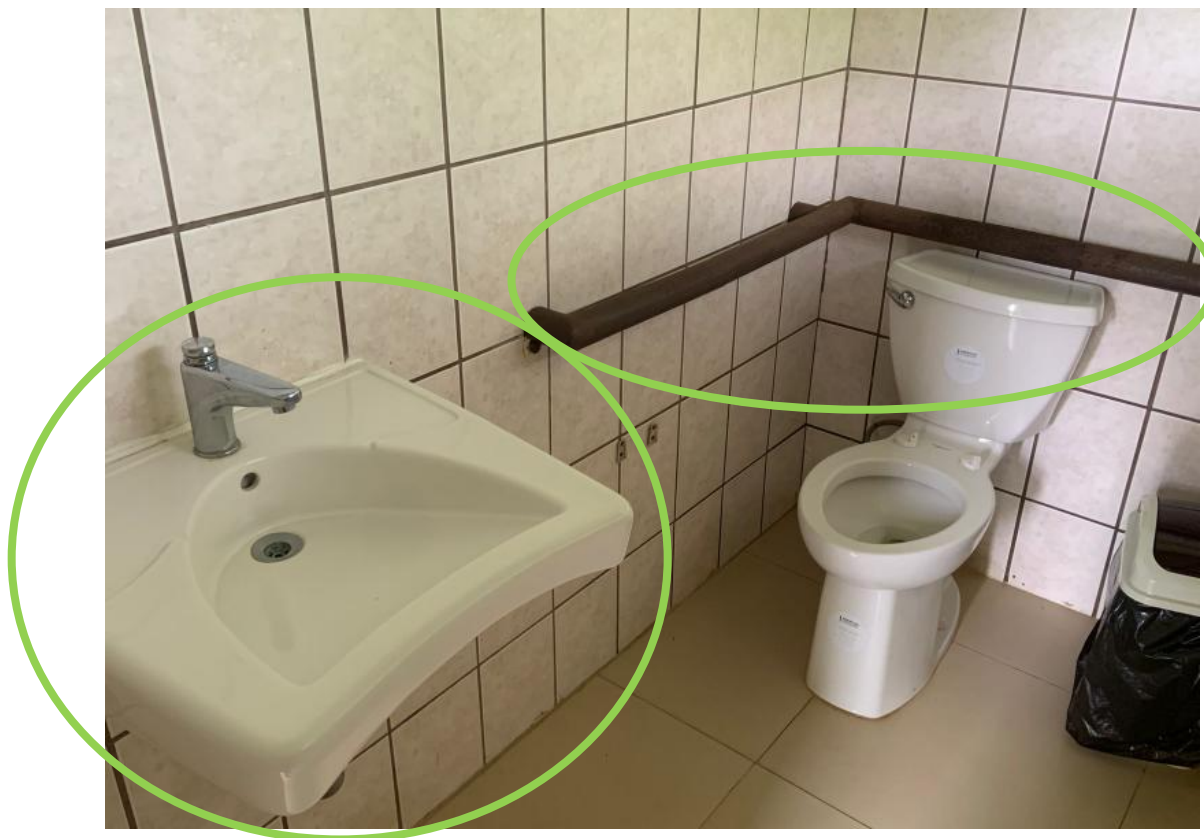
Figura 33. Servicio sanitario adaptado a la Ley N°7600
