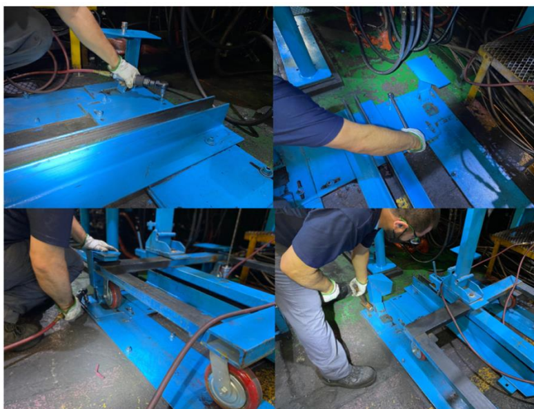
Figura 28. Modificaciones en la base de la prensa
