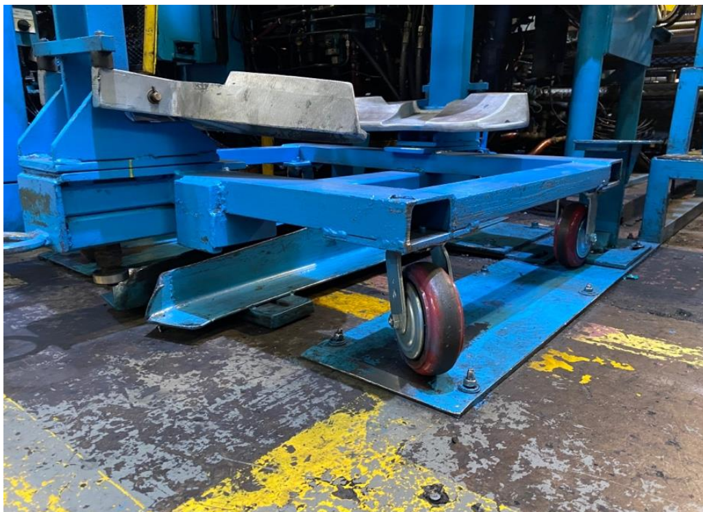
Figura 19. Anclaje de las bases de las prensas vulcanizadoras
