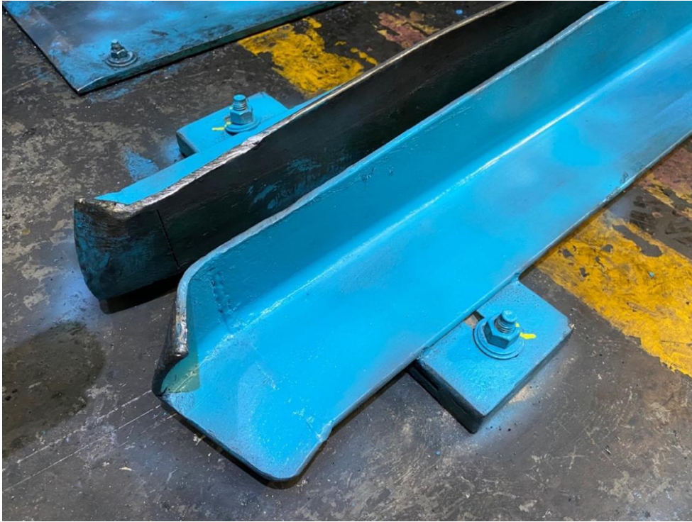
Figura 46. Anclaje de guía del centro
