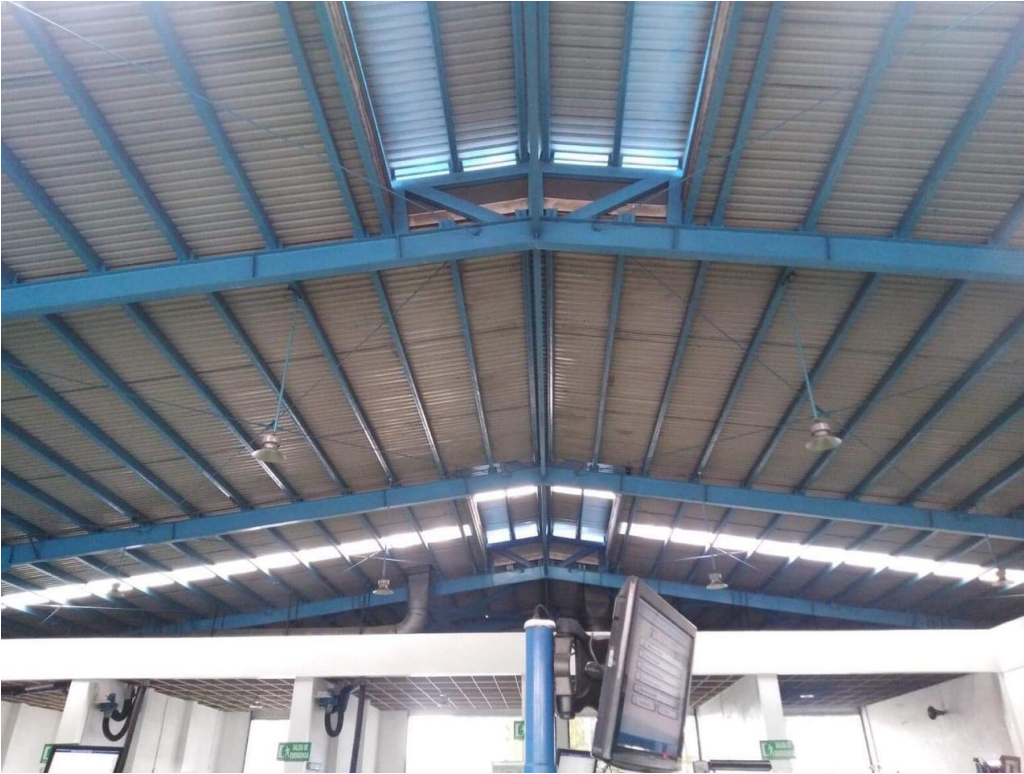
Figura 48. Techo de la estación.
