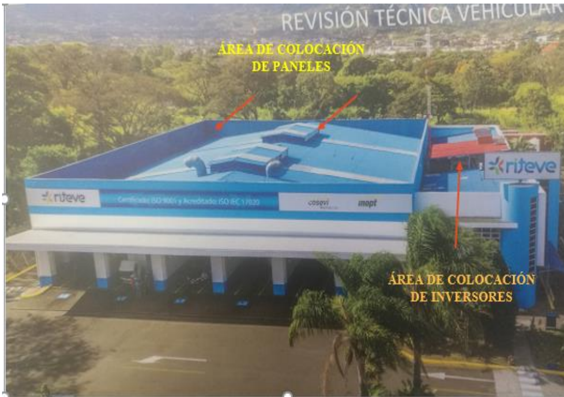
Figura 47 Ubicación propuesta para paneles e inversores en la Estación de San Miguel.
