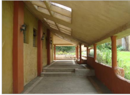
Cochera al costado Oeste y terraza
