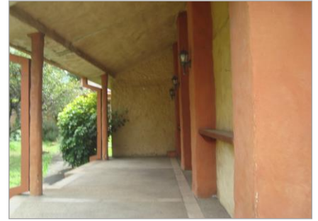
Terraza al costado Este
