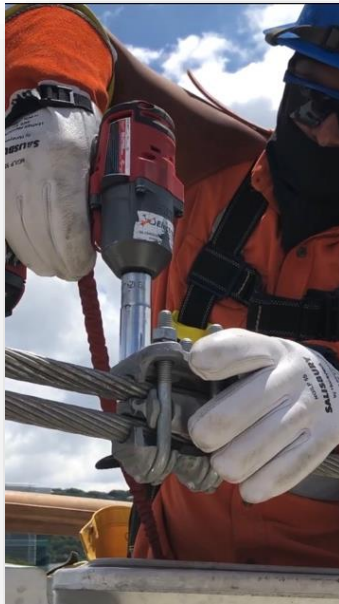
Ilustración 37. Implementación de la herramienta de soque/afloje por primera vez en labores reales
