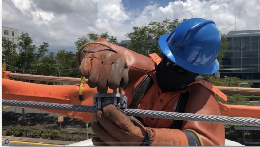
Ilustración 36. Instalación de grapa para conexión de cable
