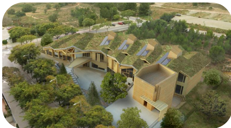
Figura 39. Ejemplo de escuela sostenible: Imagine Montessori School . Ecoconstrucción. 2019.
