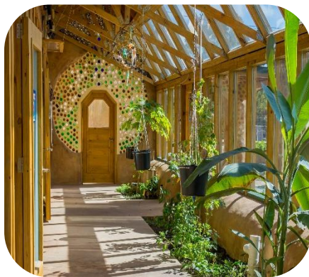
Figura 79. Pared de fondo está construida con botellas de vidrio. Tagma. S.f.
