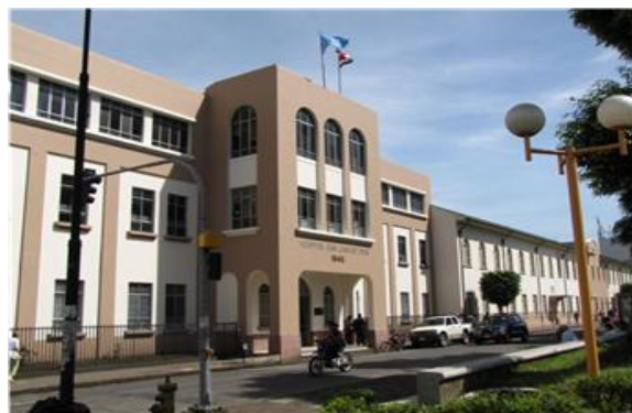
Figura 1 Imagen del Hospital San Juan de Dios.
