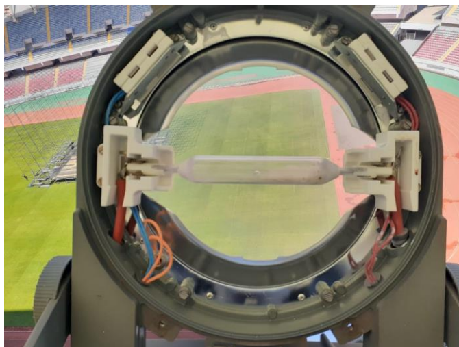
Imagen 28: Tipo de Instalación del bulbo dentro de la luminaria y configuración de la óptica y reflexión de las luminarias instaladas.
