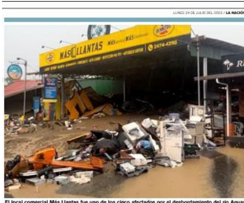
El local comercial Más Llantas fue uno de los cinco afectados por el desbordamiento del río Aguas Zarcas, en Aguas Zarcas de San Carlos (Alajuela), la tarde de este domingo. CNE
